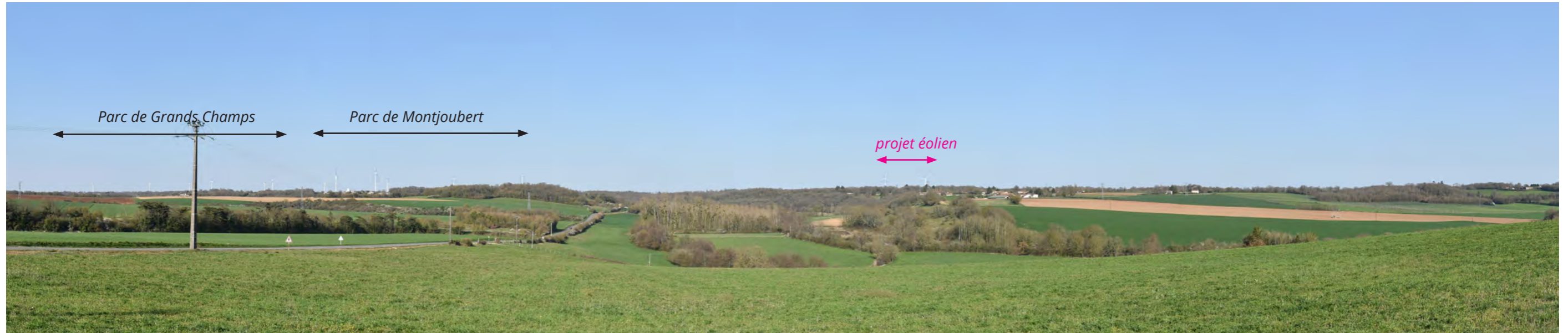
Photographie 156 : Vue sur le projet depuis la D8, au niveau de Taizie-Aizie (photomontage 9).
