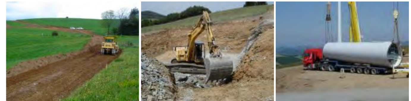
Photographie 144 : Illustration d'un chantier éolien.
