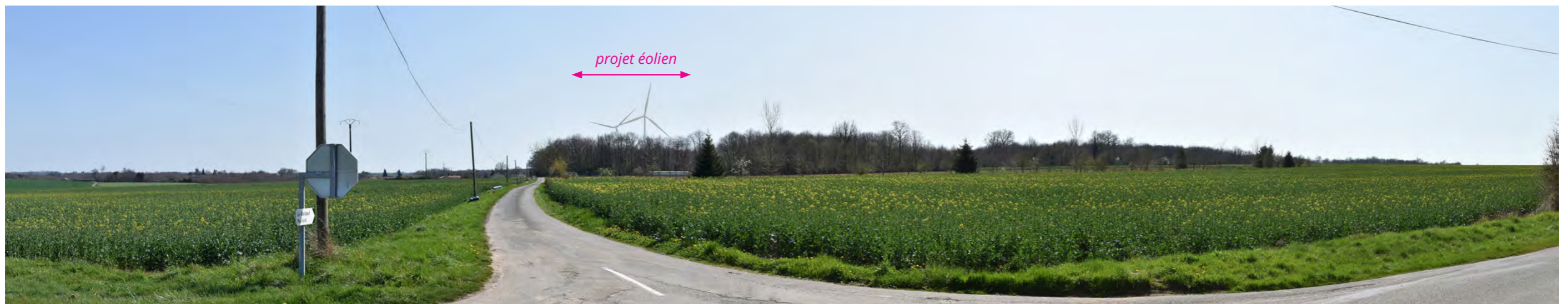
Photographie 182 : Vue latérale sur les éoliennes depuis la D107, au nord-ouest de l'AEI (Photomontage 30).
